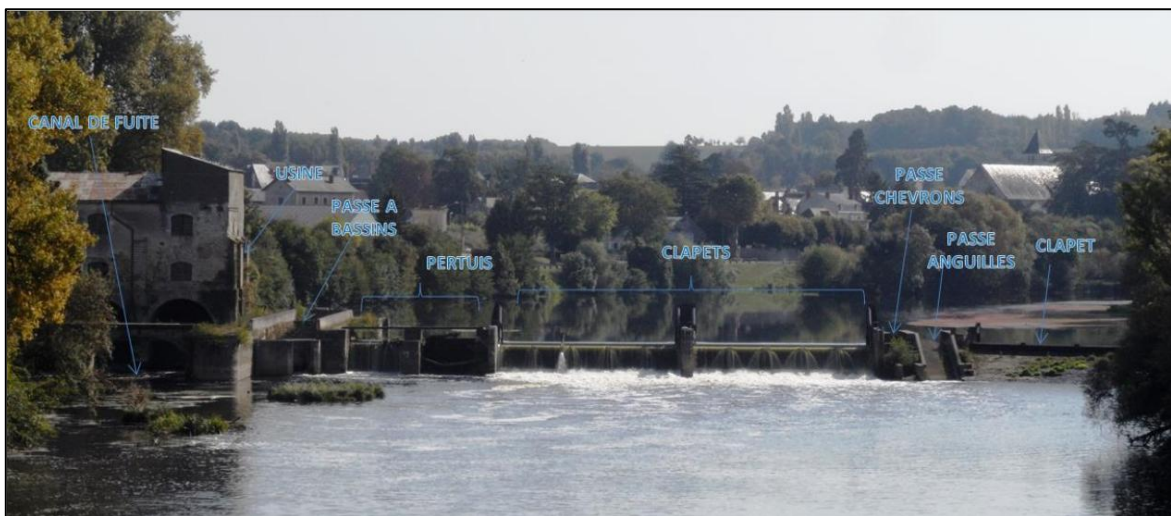
Le barrage de Descartes avant la crue de juillet 2021 ayant emporté le clapet n°4
