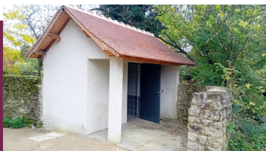
Travaux des toilettes publiques du jardin public réalisés par les Services Techniques de Descartes.
